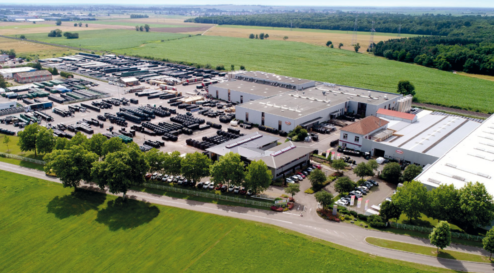
Site de production de Dachstein en Alsace
